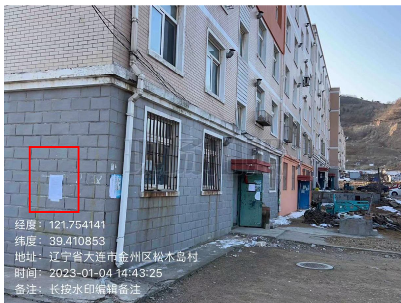
海岛新村公示张贴现场照片
